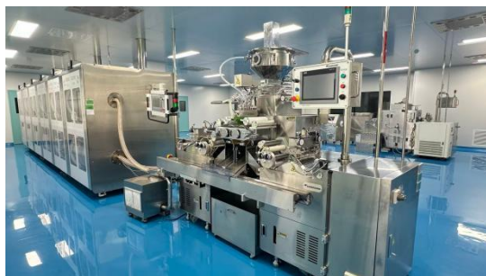
综合车间 2F：压丸机
