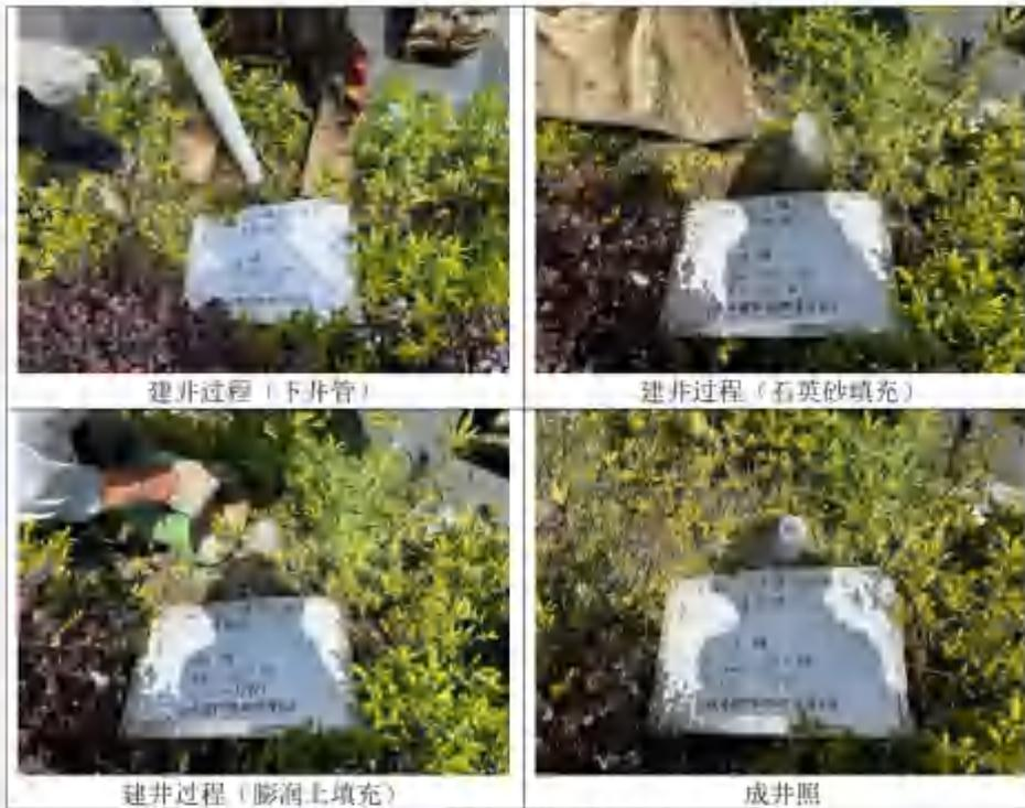
图 6 地下水监测井成井照片
