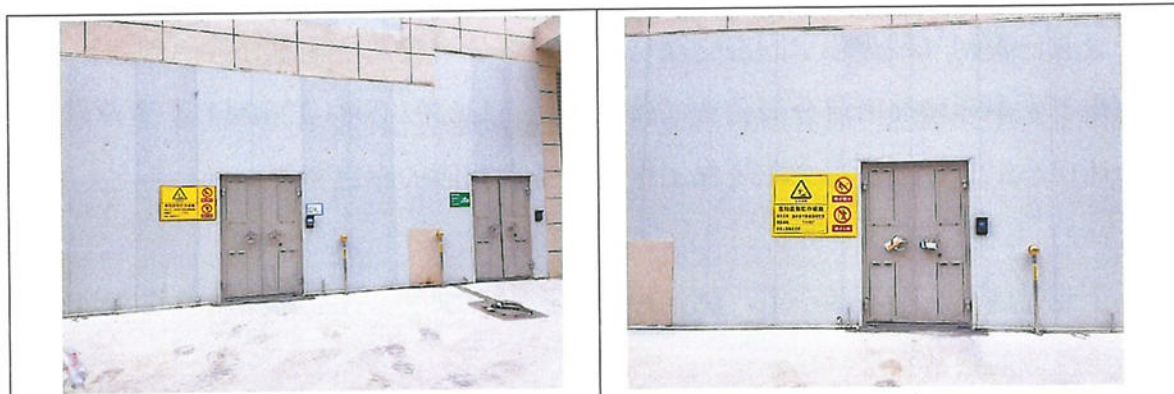
图 3.1-8 危废暂存库照片
