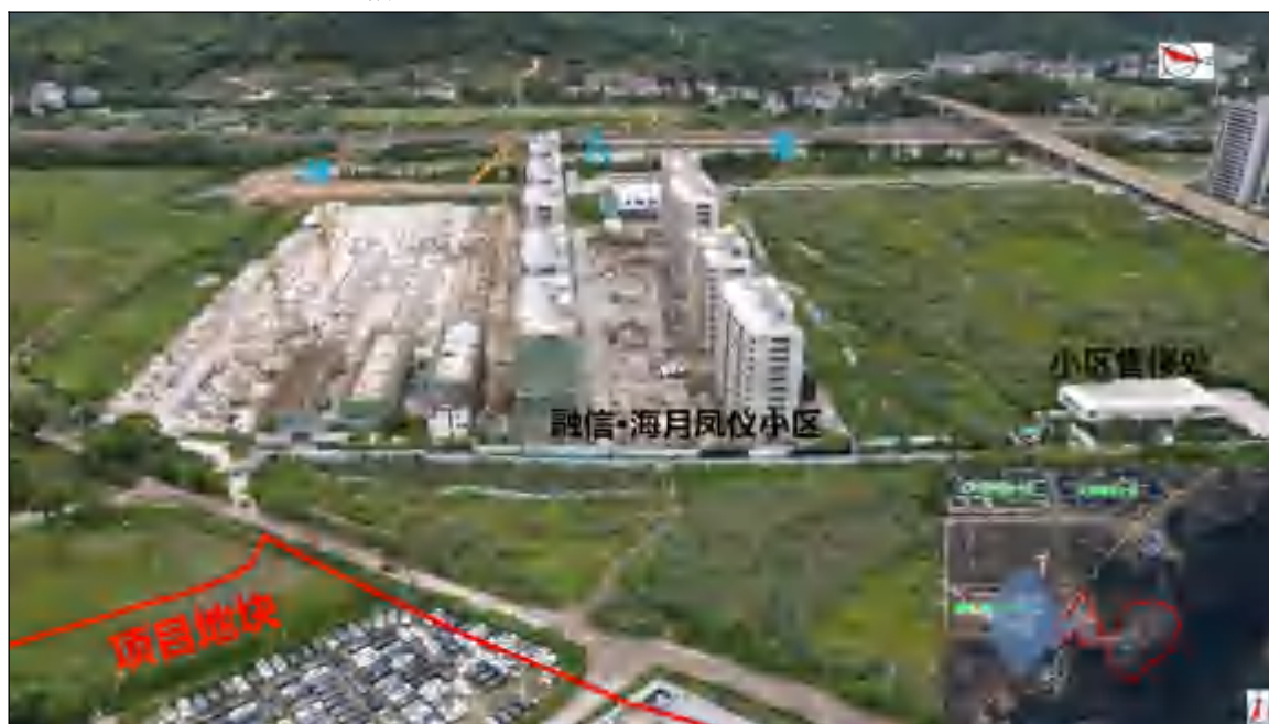
项目地块西侧
