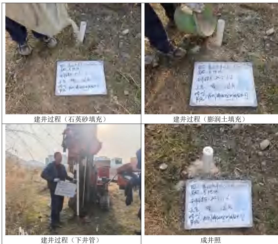
图 6.2-6 地下水监测井成井照片
