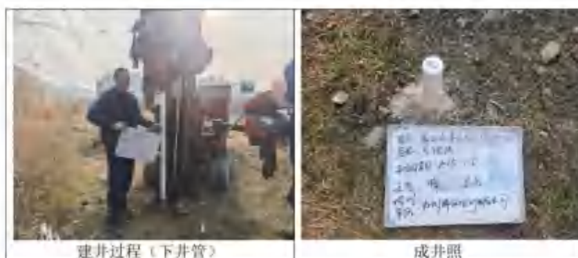
图 6 地下水监测井成井照片
