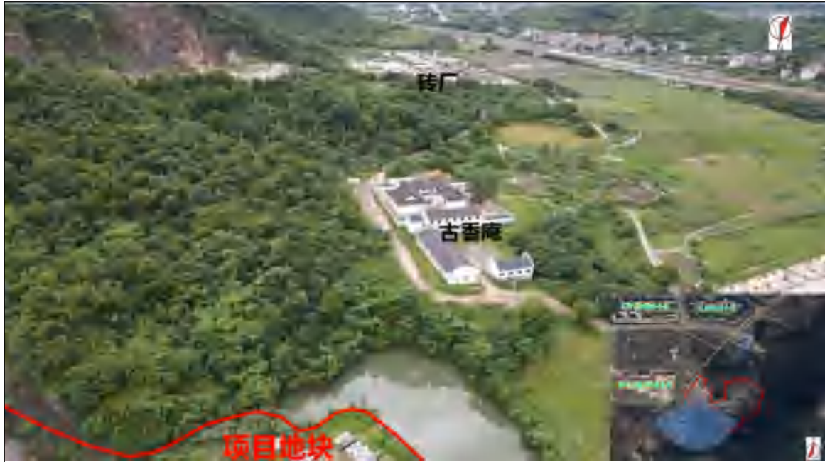
项目地块南侧
