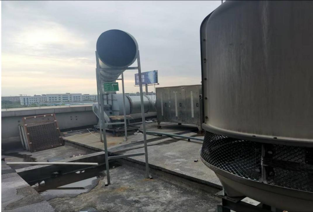
图4 加弹废气 (DA002) 处理装置
