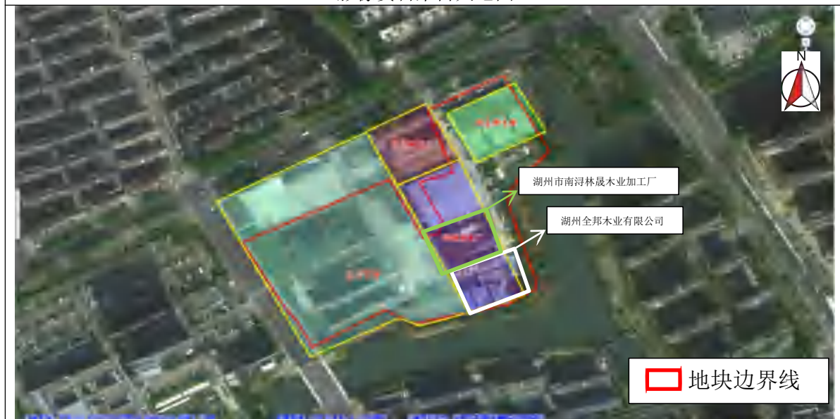
2023 年永吉木业内所有建筑均已拆除，地块西南侧原厂房位置形成多处积水。其余位置无明显变化。(影像资料来自天地图，2019 年至 2023 年无影像资料)
