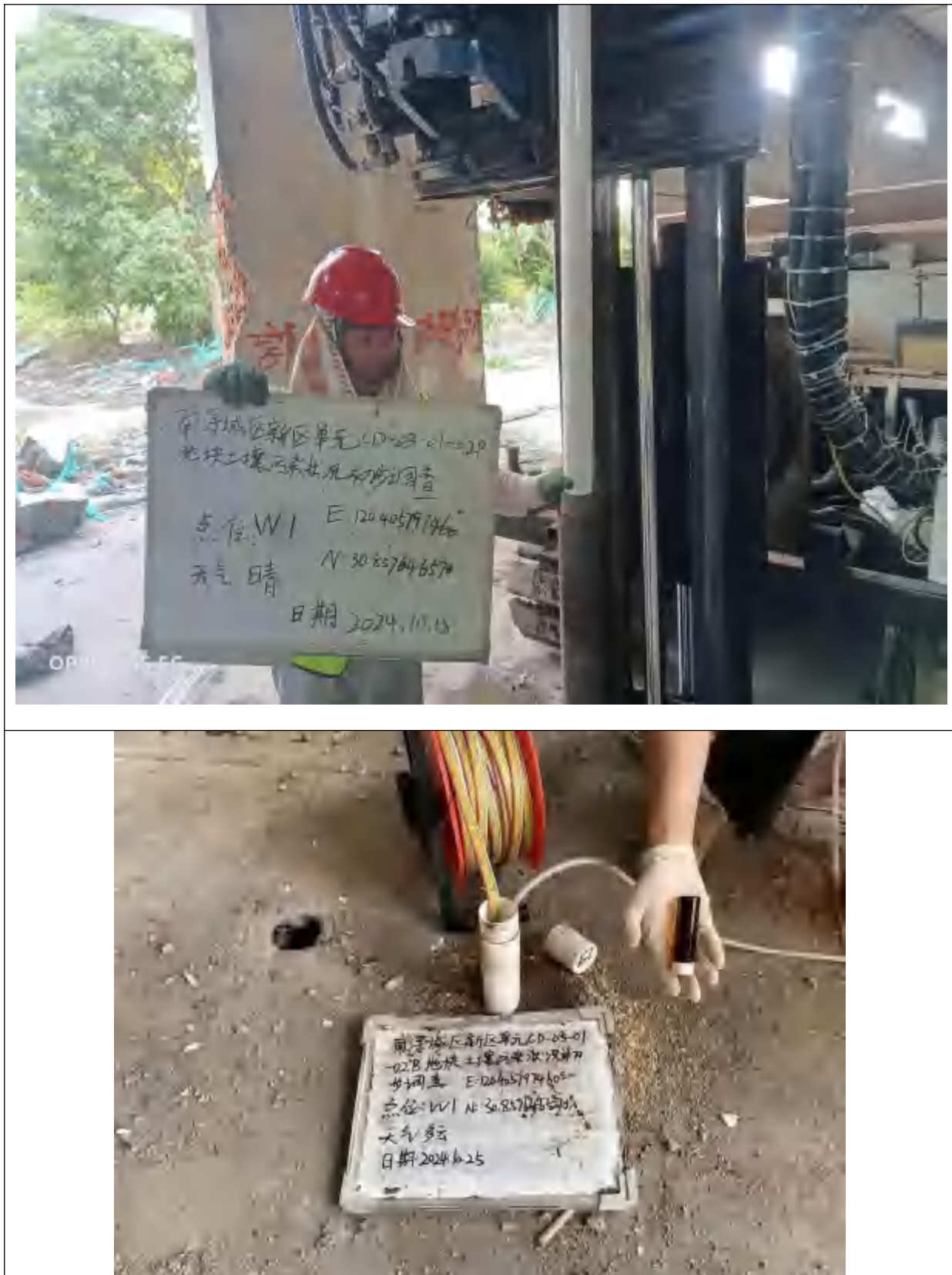
图 6.3-1 地下水监测井建井、洗井照片
