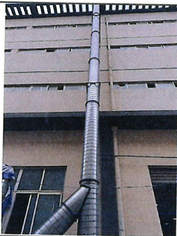
图 3-3 排气筒设施图 (DA001)
