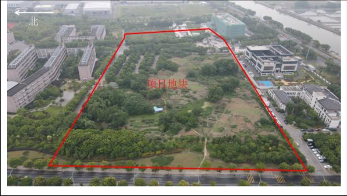
图 3.4-1 地块现状照片（2024 年 6 月航拍图）
