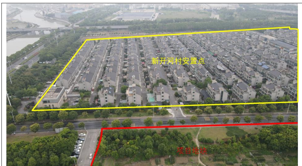
项目地块西侧
