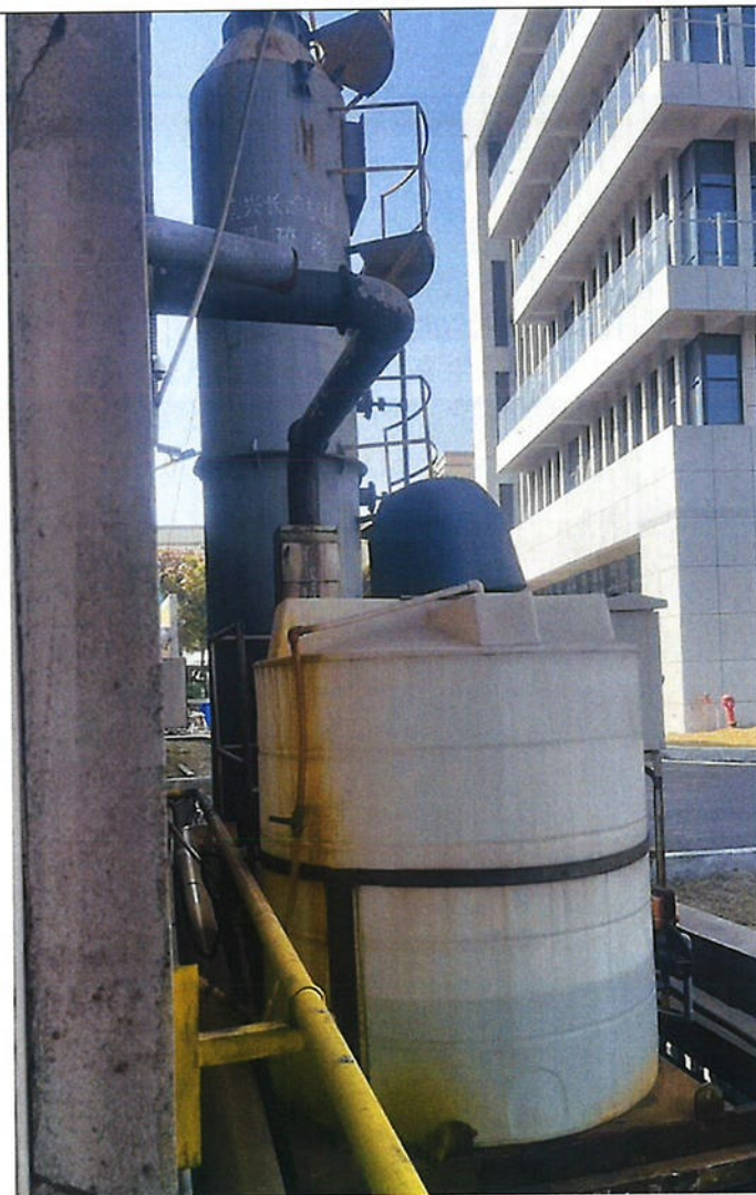
金属丝网过滤+喷淋塔装置-预烧废气
