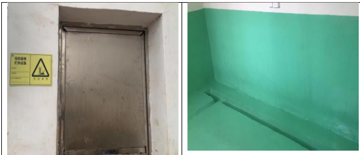
图 4.6-1 危废暂存库照片
