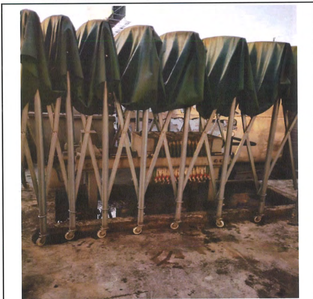
图 3 污泥压滤机加盖雨棚
