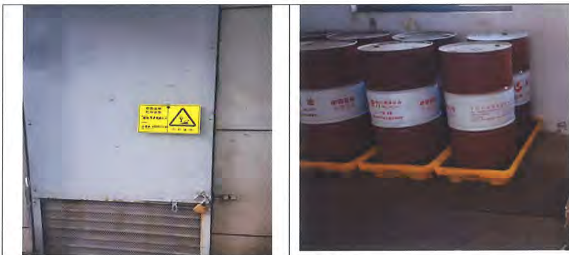
图 3.1-5 危废暂存库照片
