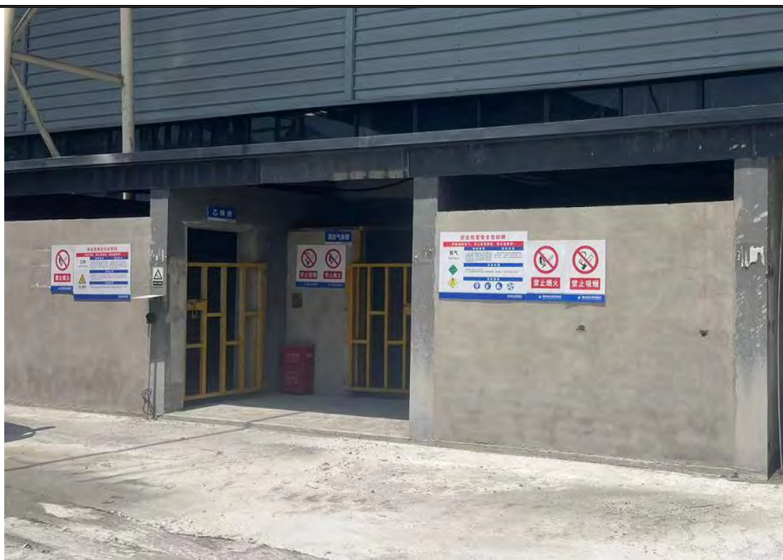
氧气仓库、混合气库、乙炔仓库
