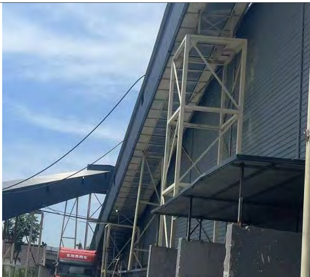
密闭输送管道
