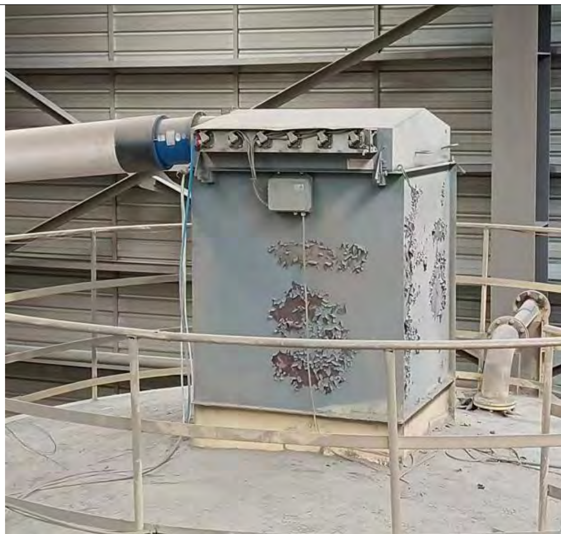
布袋除尘装置-搅拌粉尘废气
