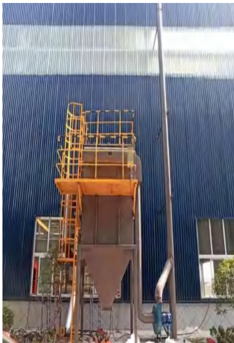
图 4-4 粉尘处理装置
