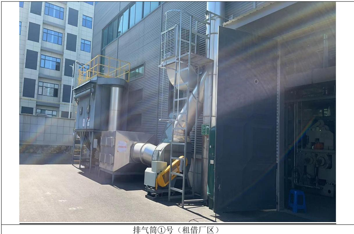
图 4.1-1 密炼废气处理设施照片
