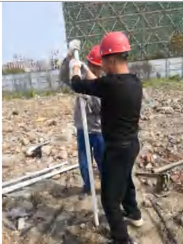
地下水建井照片
