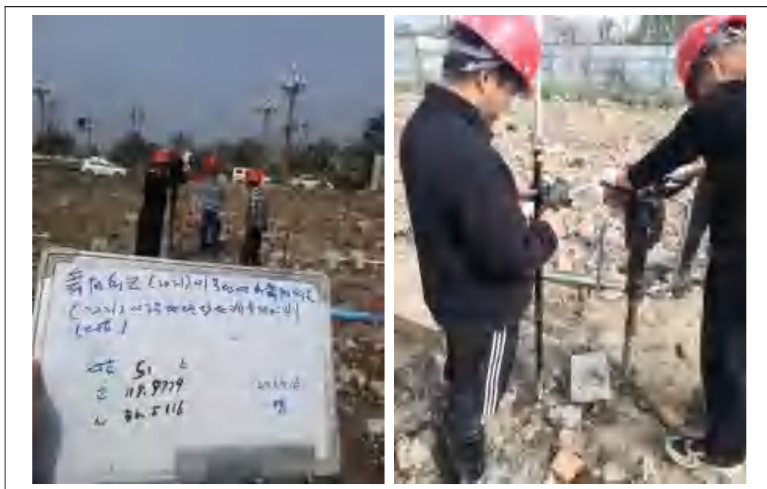
图 5.2-2 现场土壤钻探照片记录
