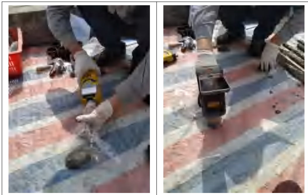
图 5.1-1 现场快速检测照片
