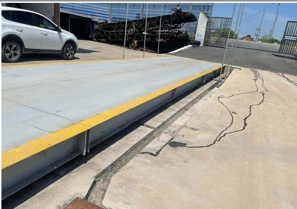
进出口洗车点及废水导流沟
