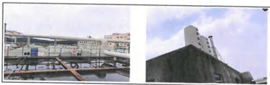
图 4-2 污水站臭气加盖收集处理
